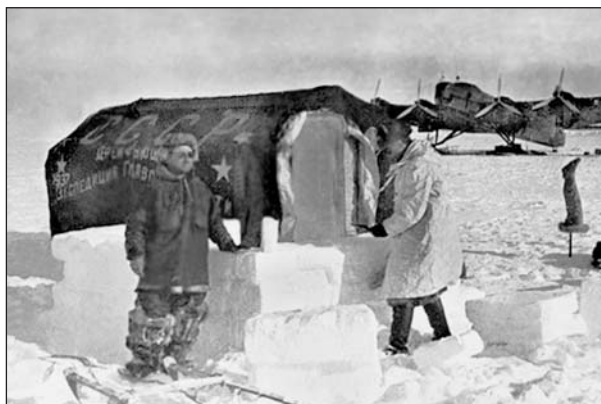
Строительство снежного тамбура к жилой палатке.
